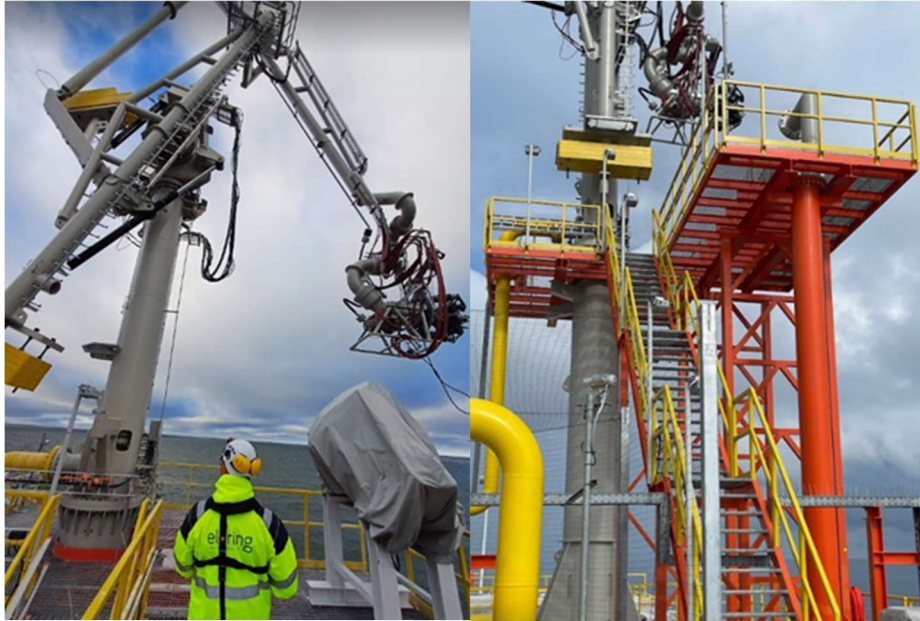
Joonis 3.6 Pakrineeme FSRU laadimiskäpp ja laadimiskäpa teenindusplatvorm
